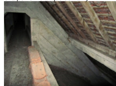
Charpente béton de Giraumont
