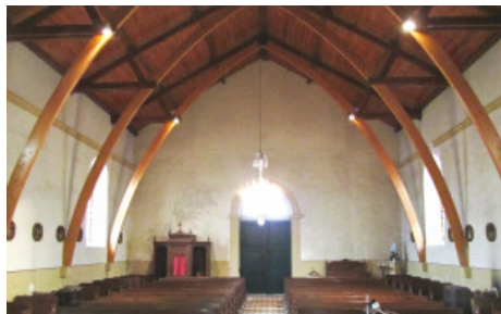
Réfection de la charpente en lamellé-collé de l'église Saint Grégoire d'Hannonville-Suzemont, architecte Jean Reitz vers 1970
