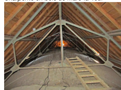
Charpente métallique de Batilly
