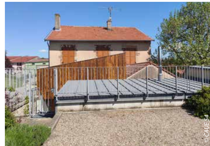
Accès à la chaufferie et au silo semi-enterré de stockage des plaquettes forestières.
