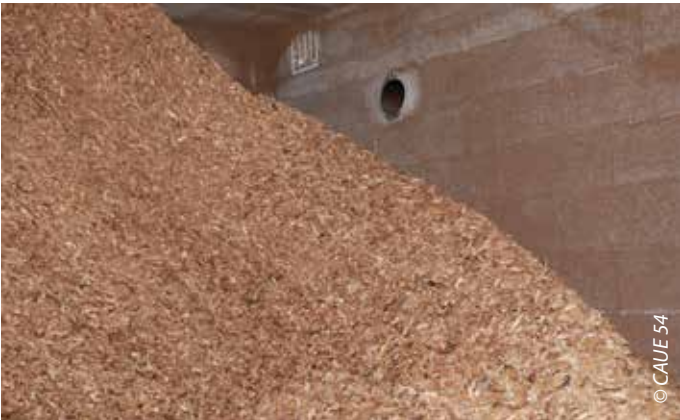
Silo de stockage des plaquettes forestières attenant à la chaufferie (Remenoville)
