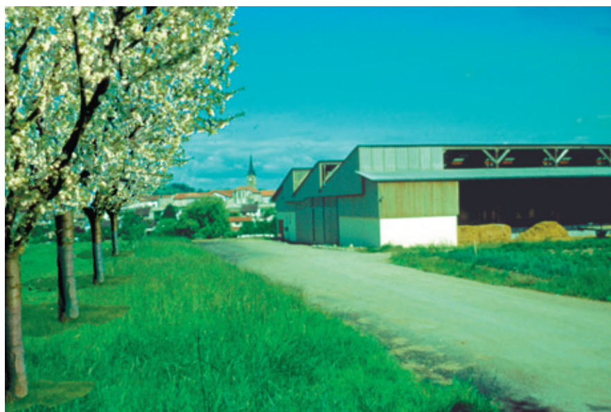
Bâtiment agricole accompagné d'un alignement de fruitiers.
